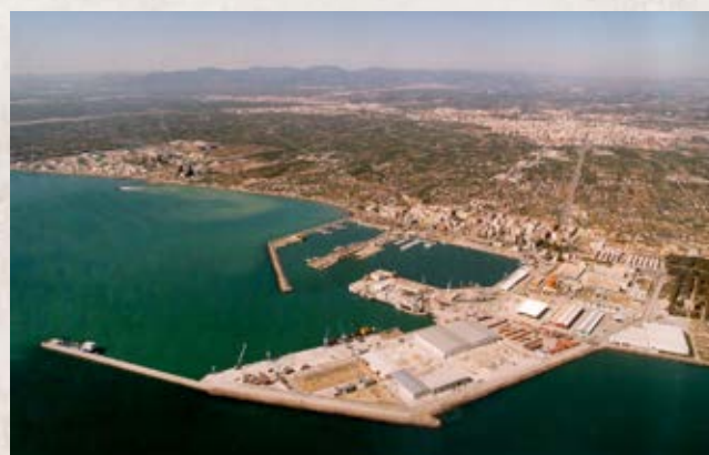
Muelle cerámica: Aspecto que presentaba en 1999 el puerto de Castellón, con la construcción entonces de lo que sería el muelle de la Cerámica.
