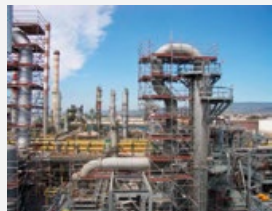
Montaje y alquiler de andamios
