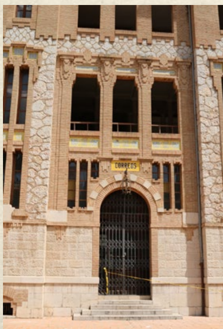
Puerta de acceso del personal.
