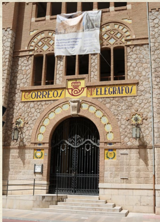
Acceso principal al público desde la calle Zaragoza.
