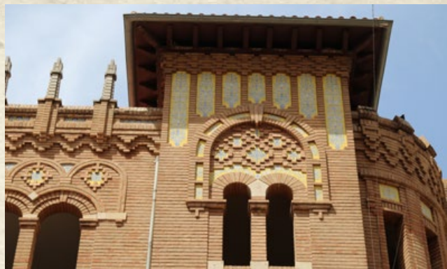
Detalle de la decoración en ladrillo y cerámica vidriada de una de las torres.
