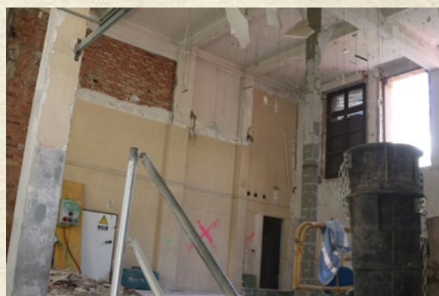
Desmantelamiento del interior del edificio como paso previo a su restauración.
