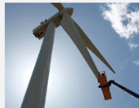
Reparación de palas en aerogeneradores
