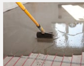
Reparación de hormigón
